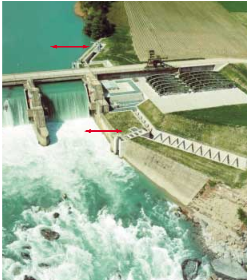
Im April 2000 konnte beim Stauwehr die Fischpassanlage in Betrieb genommen werden (auf dem Bild ist die Fischpassanlage auf der rechten Seite des Stauwehres zu sehen; Ein- und Ausstieg sind mit roten Pfeilen gekennzeichnet).
