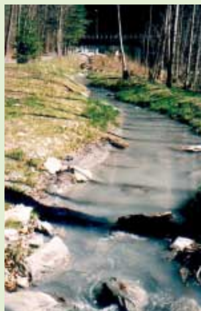
Neuer Fischbach; darunter verläuft die Druckleitung im alten Kanal
